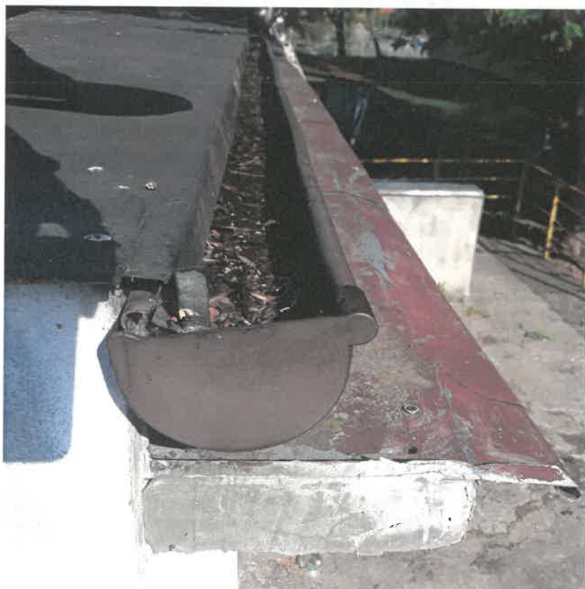
Zdjęcie nr 10. Szczegół aktualnego montażu rynny
